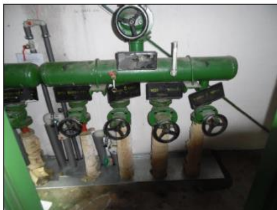
Obr. 19 sběrač větví otopné soustavy
