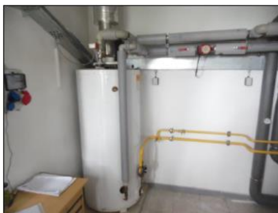
Obr. 21 plynový bojler v kotelně pro ohřev TV
