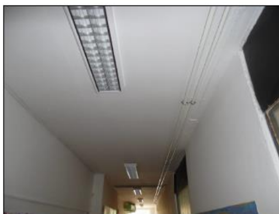
Obr. 23 zářivkové osvětlení chodby
