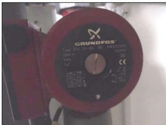
Obr. 18 čerpadlo otopné soustavy GRUNDFOS
