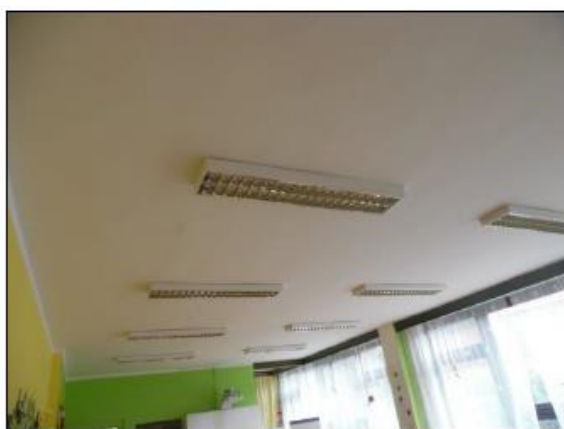
Obr. 22 zářivkové osvětlení učeben
