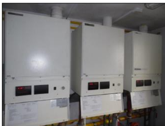
Obr. 15 zdroj tepla – plynové kondenzační kotle z roku 2002
