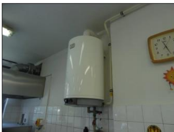
Obr. 20 plynový bojler pro ohřev TV v kuchyni
