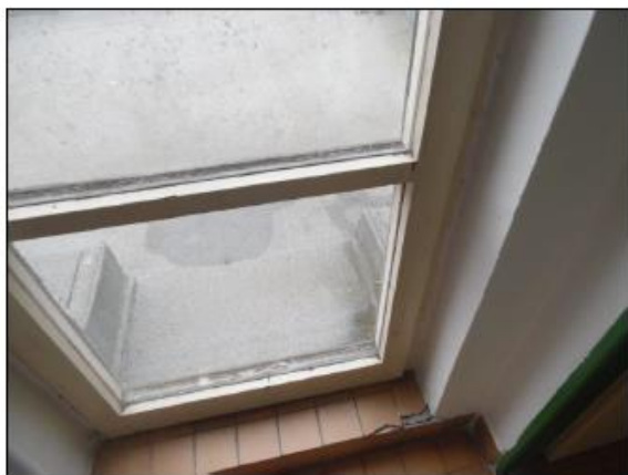
Obr. 12 dřevěné zdvojené okno
