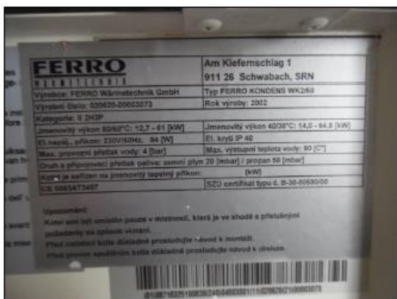
Obr. 16 výrobní štítek zdroje tepla
