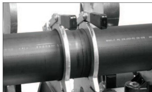
Správně připravené potrubí ke svařování
