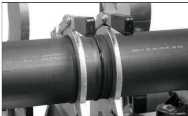
Chladnutí svařeného spoje
