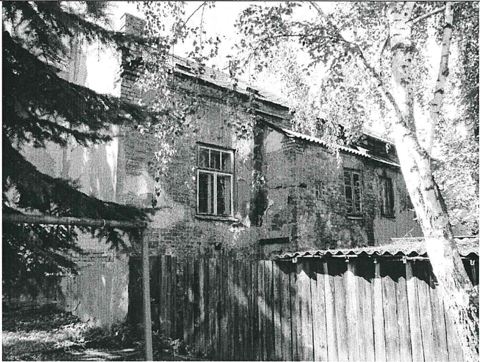
Severní pohled č.p.801
