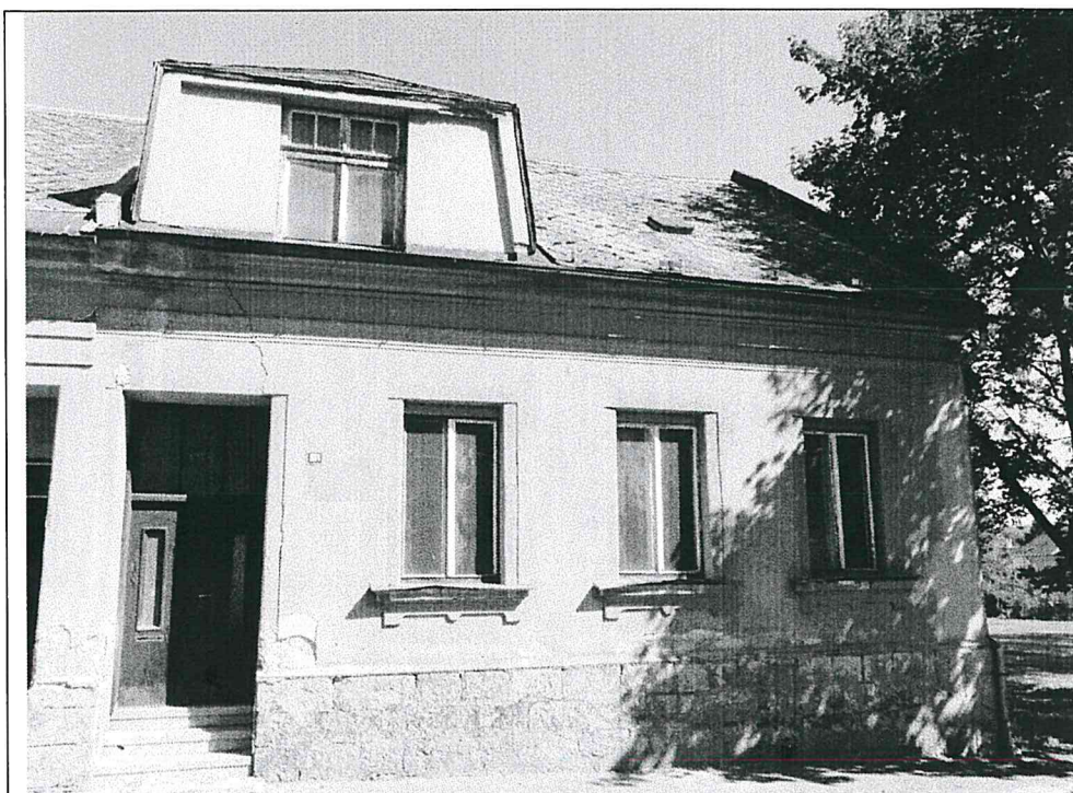
Jižní pohled č.p. 801
