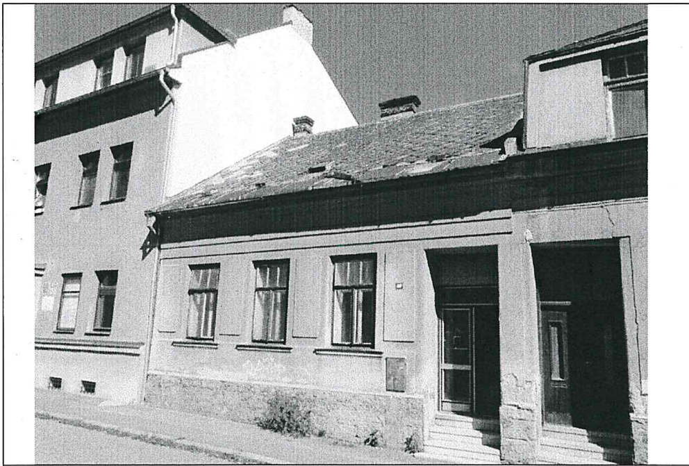
Jižní pohled č.p. 800
