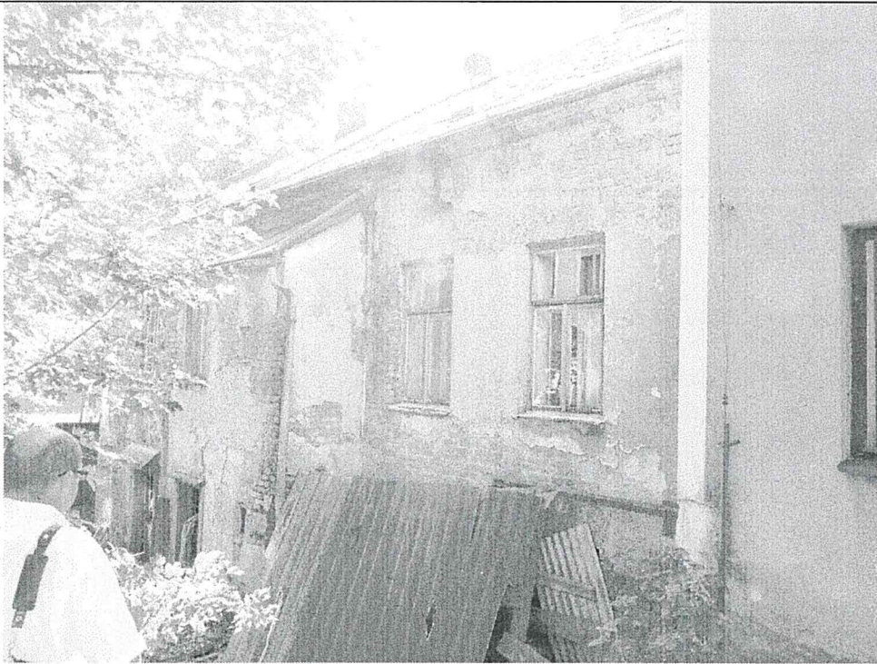
Severní pohled č.p. 800
