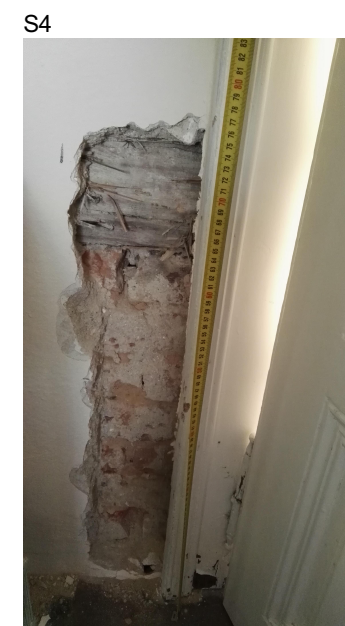
SONDA VE STŘEDNÍ ZDI SE ZAVHLÝM TRÁMEM
