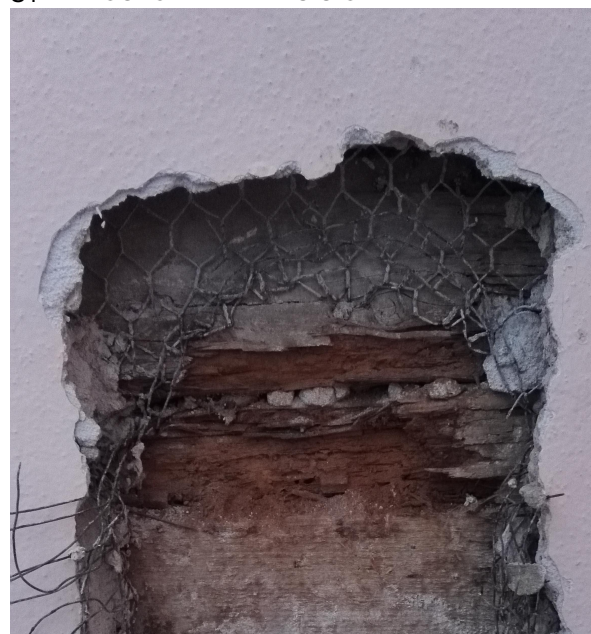
S1 POŠKOZENÍ TRÁMU U OKNA
