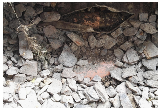
KOPANÁ SONDA DRENÁŽNÍHO PŘÍKOPU KS1
