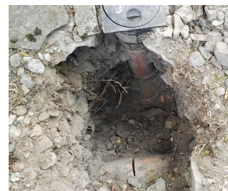
KOPANÁ SONDA KS2 - KANALIZAČNÍHO A DRENÁŽNÍHO POTRUBÍ
